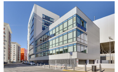
Büro Le Virage | Marseille (F)
